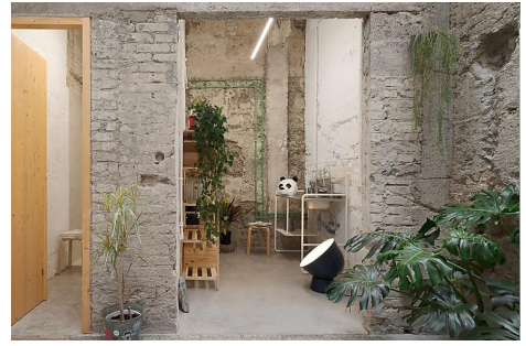
La casa che si spoglia delle sue ex sovrastrutture e torna abitabile con un...
